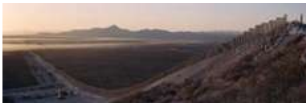
Construction de la frontière entre le Mexique et les Etats-Unis. Arizona, 2008
